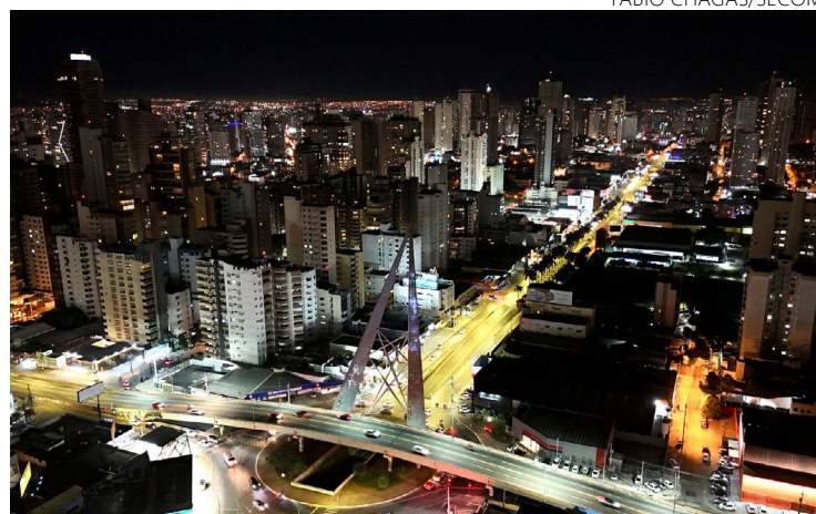
Vista aérea da Avenida 85 após finalização das obras no último sábado
